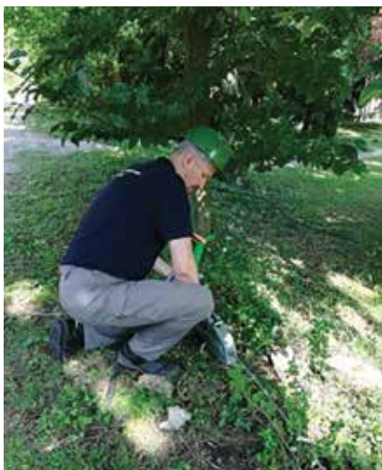
Ryc. 3.16. Montowanie liny we wciągarkę
